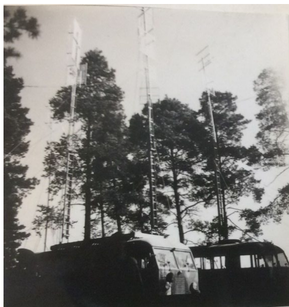
Upprättandet av en radiolänkstation Upprättad Lgc med expeditions-resp radiobuss
