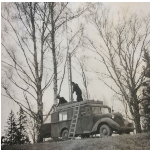
Upprättandet av en radiolänkstation Upprättad Lgc med expeditions-resp radiobuss
