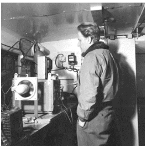
Verkstads vagn med installerad radiolänkmateriel som ändstation
